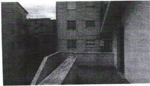
Zona ingresso al piano mansarda con terrazzo
